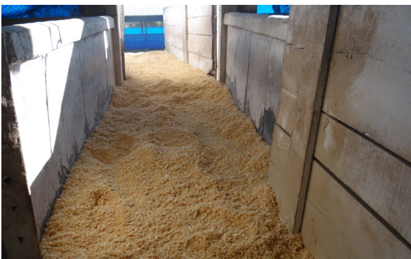
Figura 13. Embarcadouros com pisos adequados.
