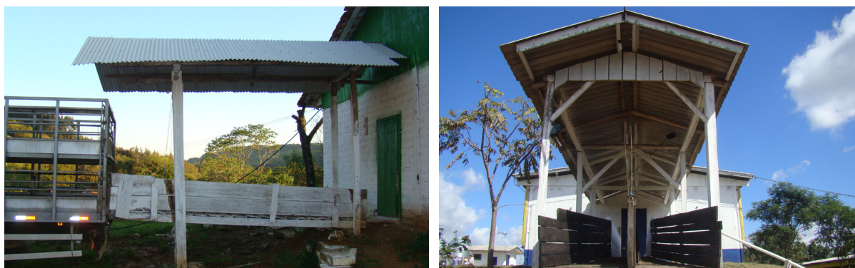
Figura 16. Embarcadouro com cobertura.
