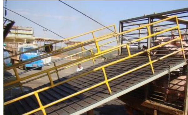
Figura 1. Rampa de desembarque no frigorífico com parede lateral vazada (modelo errado).
