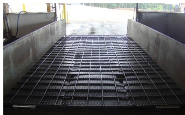
Figura 3. Rampa de desembarque para suínos no frigorífico com piso liso e defeituoso.
