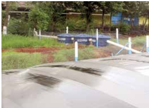
FIGURA 03 | Sistema de captação da água chuva que cai no telhado da granja, filtragem da água coletada e cisterna
