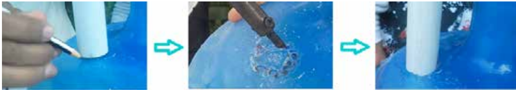
FIGURA 19 | Montagem do biodigestor caseiro: passo 2
