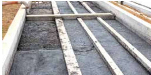
FIGURA 12 | Decantador de alvenaria utilizado para fazer a separação das fases dos dejetos suínos
