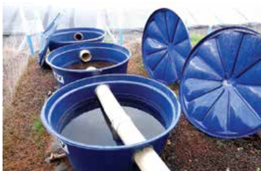
FIGURA 04 | Conjunto de filtros utilizados para limpeza da água da chuva antes da armazenagem nas cisternas
