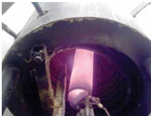
FIGURA 32 | Uso da energia térmica do biogás para o aquecimento da água para banho doméstico.
