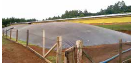
FIGURA 15 | Biodigestor de batelada em funcionamento
