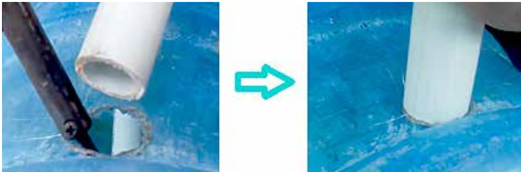
FIGURA 20 | Montagem do biodigestor caseiro: passo 3
