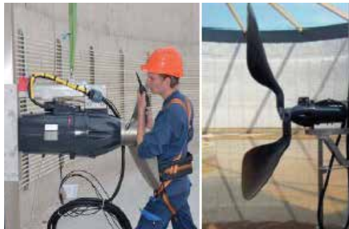
FIGURA 13 | Instalação dos agitadores submersos.
