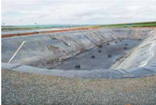
FOTO 12 | Biodigestor em construção, solo revestido com manta plástica impede a infiltração do dejetos no solo.
