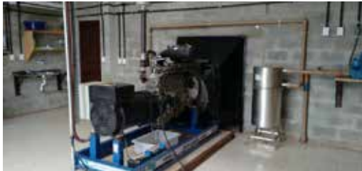
FOTO 23 | Gerador de energia a biogás com sistema de filtragem prévia do gás sulfídrico.
