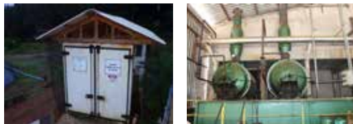
FIGURA 09 | Câmara de congelamento de carcaças de suínos mortos no processo produtivo de produção de farinha de carne e ossos.
